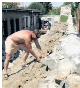
Na hradební zdi v centru města se pracuje. Foto: P. Janeček MF DNES
